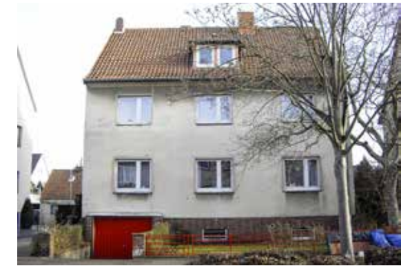
Sonnenweg 25, vor den Sanierungsmaßnahmen
