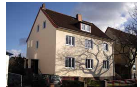
Sonnenweg 25, nach den Sanierungsmaßnahmen
